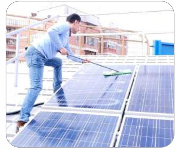
Limpeza de painel fotovoltaico no campo de teste com NT70 Solar
